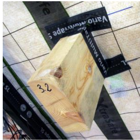
Figuur 18: Luchtdichte afwerking rond balk met tape
