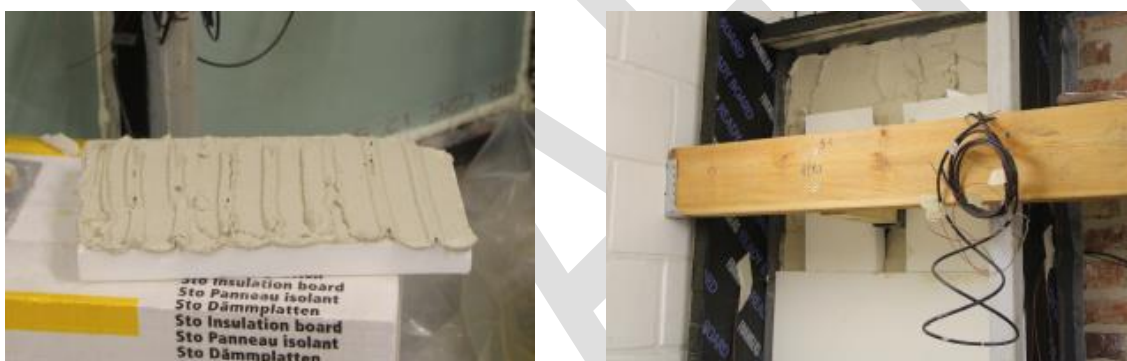
Figuur 20: Binnenisolatiesysteem op basis van aerogel. Door de zeer gunstige \lambda -waarde kan er zelfs met een zeer dunne plaat een goede warmteweerstand bereikt worden.
