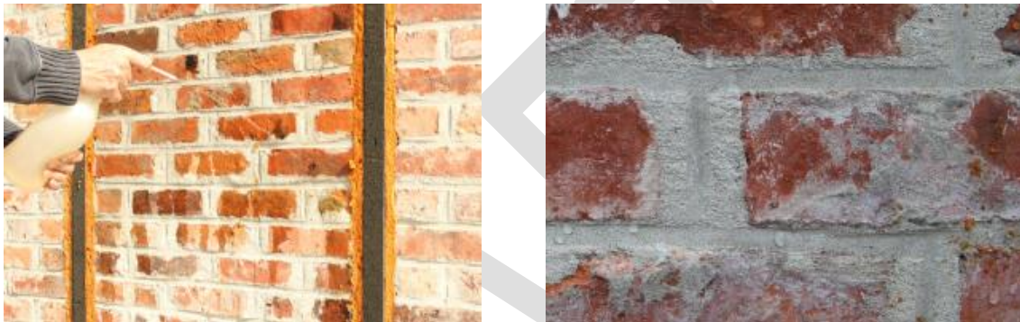
Figuur 24: Aanbrengen van waterwerende oppervlaktebehandeling (links) zorgt dat de waterabsorptie daalt (druppelvorming op het oppervlak, rechts)
