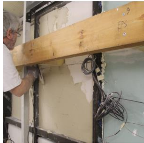
Figuur 22: Binnenisolatiesysteem op basis van geëxpandeerd perliet
