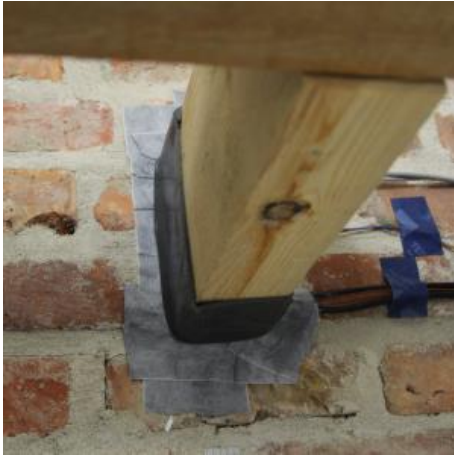
Figuur 21: Luchtdichte uitvoering via tape en band
