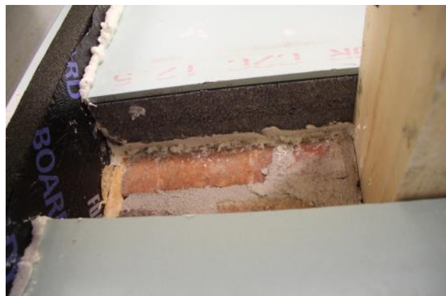
Figuur 28: Geen isolatie naast de balken, als men het plafond en de vloer niet wil of kan openbreken
